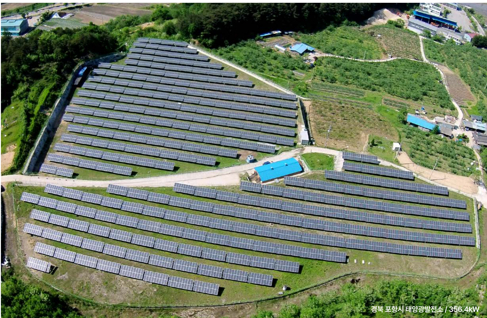
경남 사천시 태양광발전소 / 206.72kW
